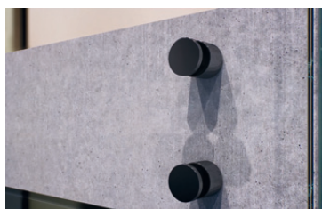
Specifický krycí element z přední části zabezpečuje estetický vzhled bez viditelných šroubů a případných poškození přítlačné části bodového úchyty při montáži.
